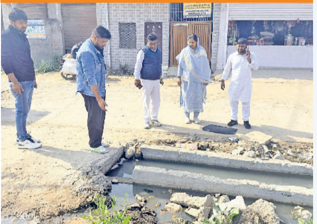
बहादुरगढ़। निर्माण कार्य का निरीक्षण करती चेयरपर्सन सरोज राठी।
